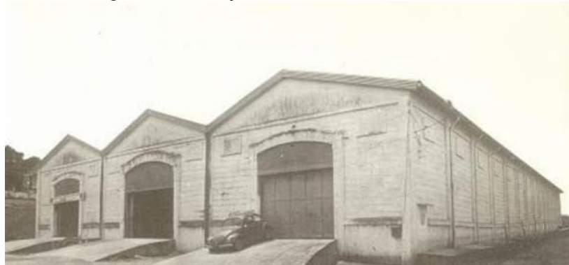
Figura 4: Edificação antes da reforma do teatro.
