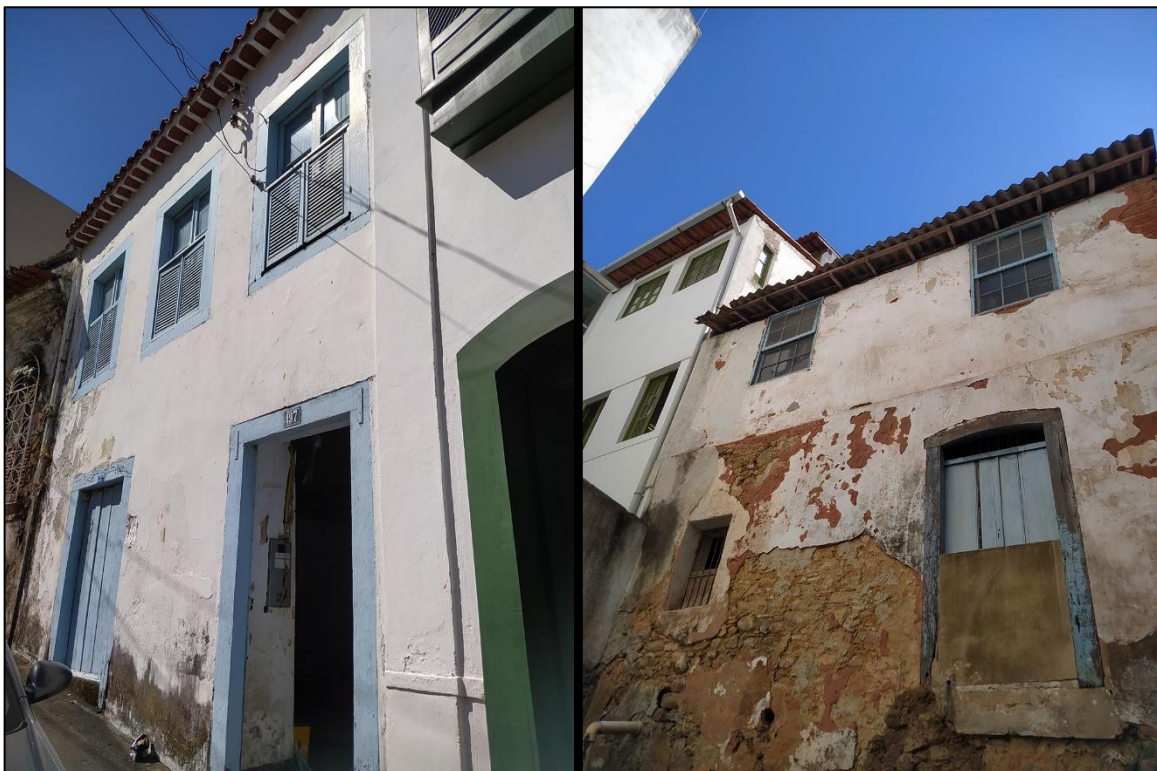
Figura 06 – Aspecto atual das fachadas frontal e de fundos da casa nº 197
