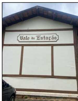
Figura 17 - Fachada lateral da Estação Ferroviária Vale da Estação
