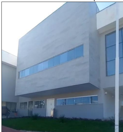
Figura 7 – Fachada frontal do salão (Antes da intervenção)
