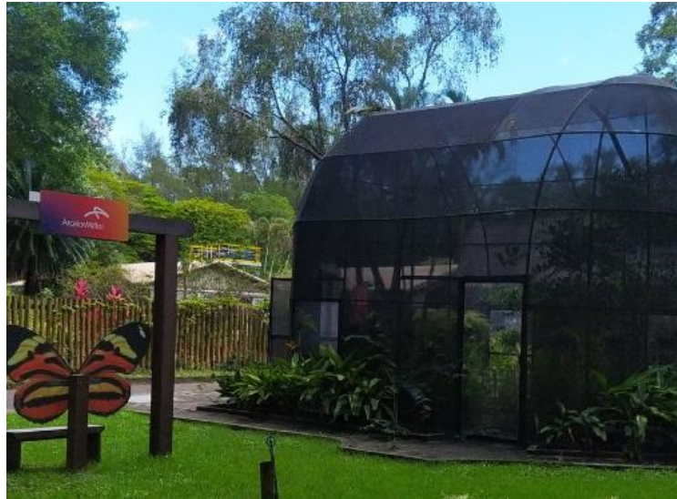
Figura 3: Borboletário Arcelor Mittal Tubarão – Vista externa da estrutura
